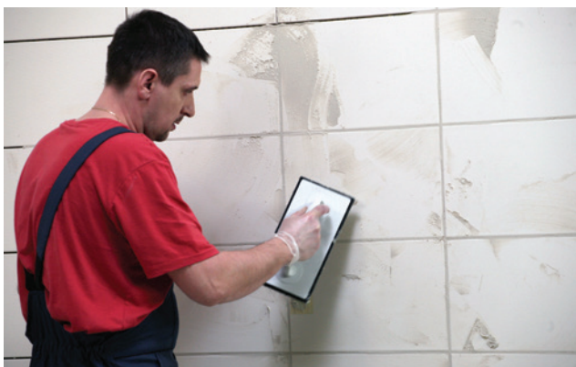
CE 40 zatrite dôkladne gumovou stierkou do škár medzi obkladmi tak, aby boli škáry úplne vyplnené.
